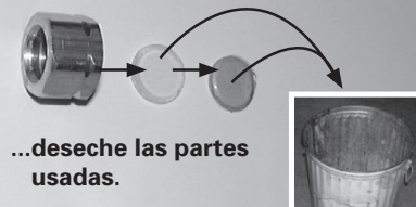
10. Instale el nuevo cartucho y el nuevo empaquetadura.
